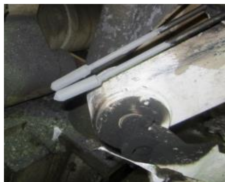
施工後, アルミ付着無し 2直稼働, 1WEEK ノーメンテナンス
